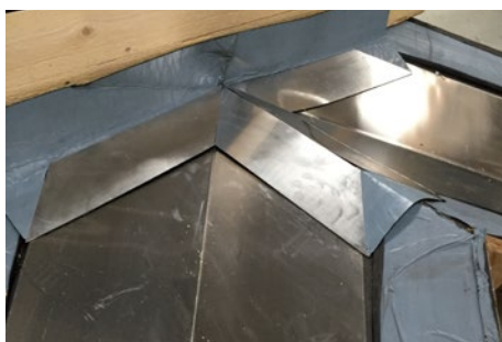
8. Nu ska vi have monteret pappet op af kip lægten. Dette kan gøres med papsøm eller klammer.
