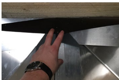
4. Pappen op mod kiplægten folles ned, så vi kan trykke fladerne med aluminium fast.
