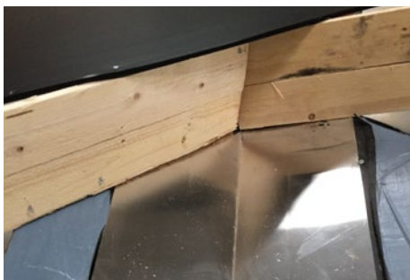
2. Skotrende profilerne klippes til op mod kippen.
