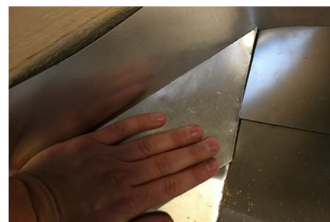
6. Derefter monteres venstre side af toppen, hvor den smigskåret del klæbes fast til butylen.
