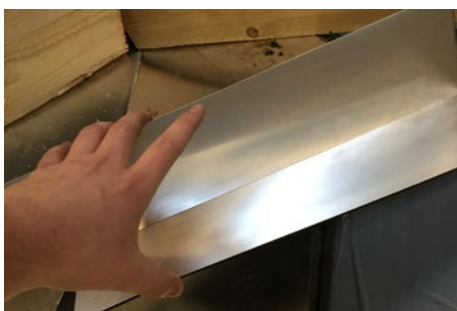
5. Nu monteres højre side af toppen. Dette gøres ved af folde toppen i 90° grader og trykkes på plads ned mod skotredens (det er nu butyltappen skal bruge).
