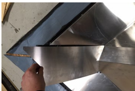
7. Den medfølgende blindplade tilpasses i smigen, så den kan monteres oven på skotrenden.
