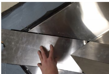
8. Nu bliver blindpladen så monteret på pappet.
