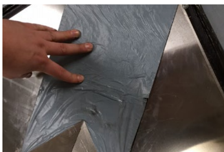
5. Nu trykkes pappet fast op af fladen på de to skotrender.
