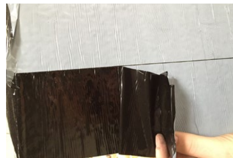
3. Folien fjernes på bagsiden af Win-Toppen, så den er klar til montage (evt. med varmeblæser eller Win2).
