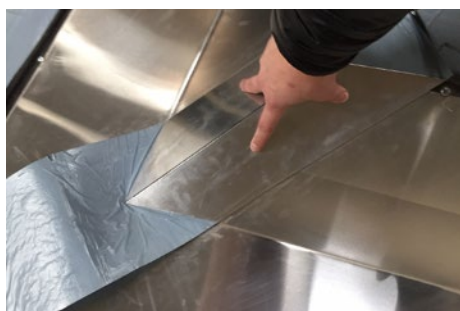
4. Nu trykkes Win-Toppen ned over de to flader på skotrende. Pappet for oven ligger løst - klar til montering efterfølgende.
