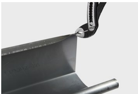
Opbukning af bagkant inden påmontering af endebund.
