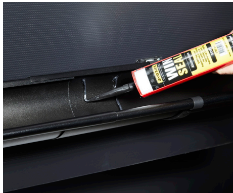
Der påføres Bygtjek Win Seal lim.
