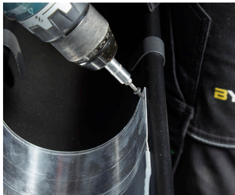
Ekspansionsstykket skrues så højt op som muligt i forkanten af tagrenden.
