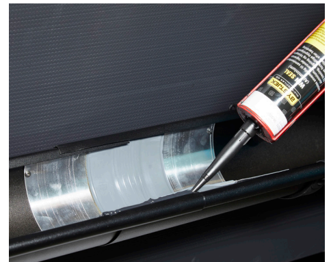
Ekspansionsstykket limes langs forkanten af tagrenden.
