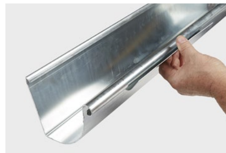
Vulst køres et stykke ind på tagrende, så den ikke er i vejen.
