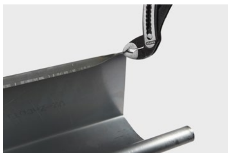
Opbukning af bagkant på tagrende inden påmontering af tud.
