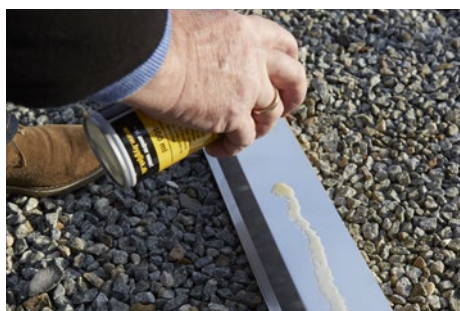
Win2 Tagfodsklæb sprøjtes direkte på tagfod.
