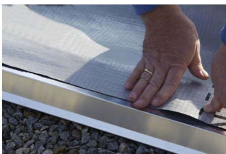
Pres undertaget på tagfod med flad hånd henover limningen.
