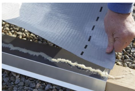
Monter herefter undertag på tagfod.
