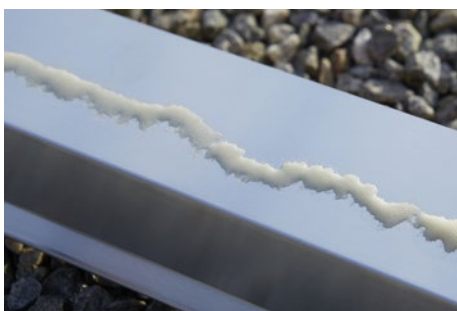
Lad Win2 Tagfodsklæb tørre i ca. 30 sek. inden du monterer undertag.
